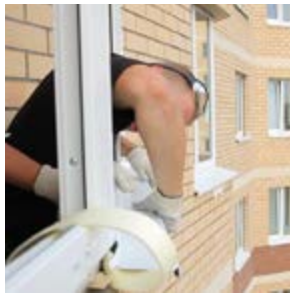
Установка отливов
