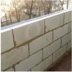
Кладка из пеноблоков под теплое остекление ПВХ
