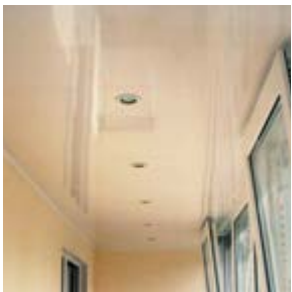
Электрика: установка светильников, розеток
