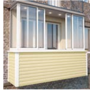
Обшивка парапета сайдингом снаружи
